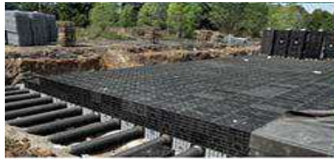
Depósitos de infiltración
